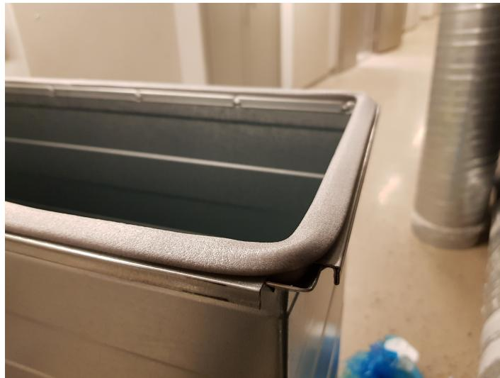
Figur 3.16: Koppling för det rektangulära kanalsystemet.
