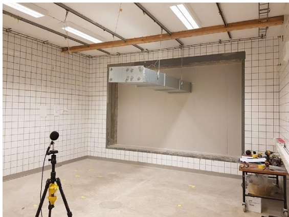
Genomföring av rektangulär kanal i vägg.
